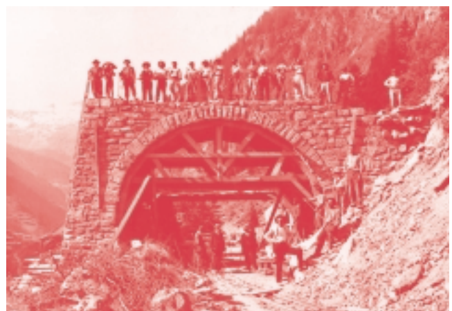
Construction d'un tunnel Photo: Giovanni Ruggeri, Collection Herzog, Musée national
